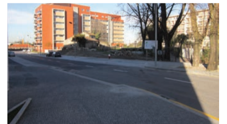
Em fase final de construção
