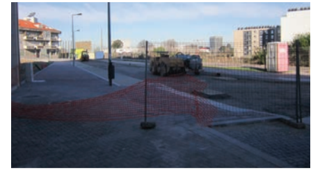
Decorrem obras de alargamento
